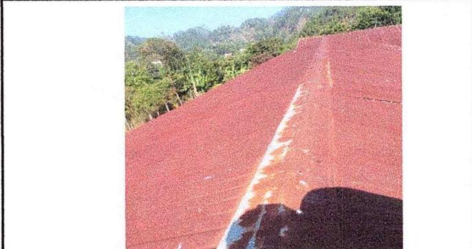
Foto1: Aquí se evidencia que el techo de la escuela esta muy deteriorada. (Módulo #3)
