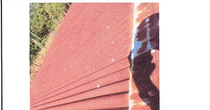
Foto 2: El módulo #2 Se ve que las láminas tiene varios agujeros.
