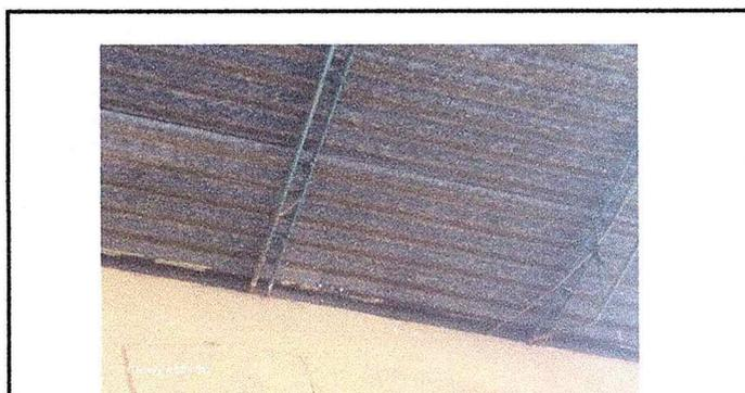
Foto 5: Se puede apreciar que las láminas no estan muy seguras y no tiene costaneras.
